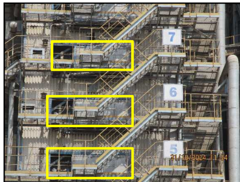
ภาพที่ 3.84 Casing ทุ้มชุด Hammering Equipment ในหม้อไอน้ำ
